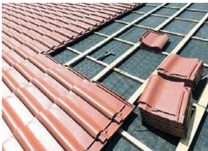
Lo scopo delle membrane traspiranti, freno o barriera al vapore per la protezione del tetto, è quello di regolare il passaggio del vapore attraverso il tetto e quindi di evitare il fenomeno della condensa negli strati interni del pacchetto costruttivo.
